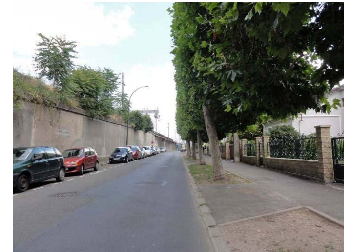
Photographie 81 : Emprise contrainte ayant nécessité de réaliser un mur de soutènement (DSC01798)
