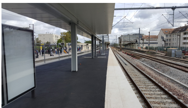
Réalisation de l'enrobé des quais et pose de l'abri filant
