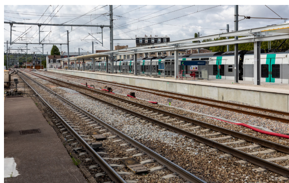
Vue du quai réhaussé quai C/D
