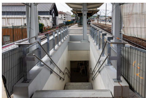
Descente d'escalier avec rampe accessibilité
