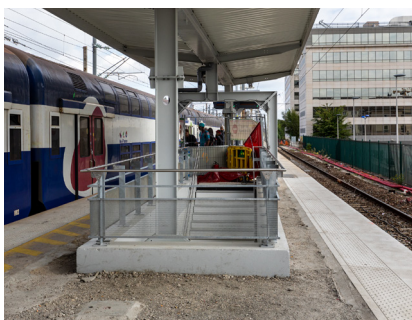
Vue de la future nouvelle sortie sur le quai
